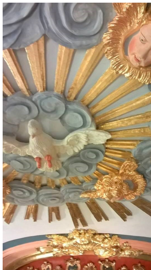
Dorure au laitton sur le médaillon et polychrome à l'huile. Chaux et dorure à l'or.
