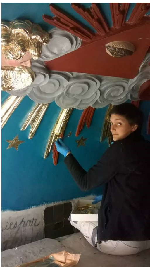
Dorure au laitton dans le baldaquin du chœur par Charlotte Beghain
