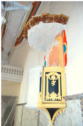
Pendant la restauration
